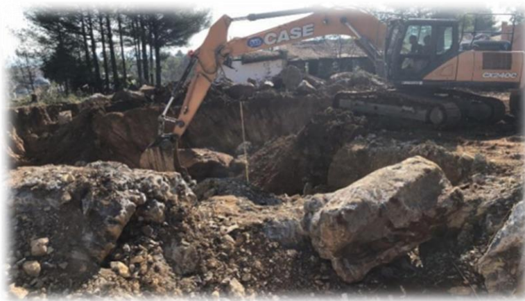
图 3.4：基岩开挖 Bedrock excavation
